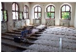
Bodendämmung EG über offenem Gewölbe
