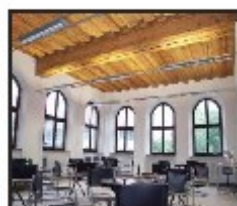
Raum innen nach Sanierung
