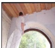
Einbau Innendämmung
