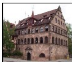
Gebäudeteil Süd Sandstein
