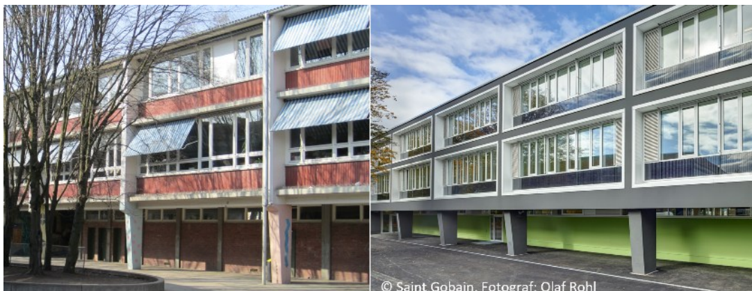
Südfassade der Uhlandschule vor (links) und nach (rechts) der Sanierung
