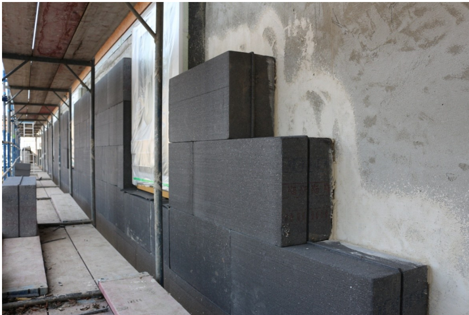
Landeshauptstadt Stuttgart: Wärmedämmung an der Uhlenschule
