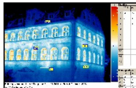
Thermografie nach Komplettsanierung Gebäudeteil Süd 2011
