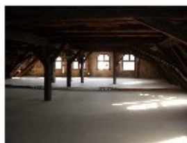
Dämmung oberste Geschossdecke
