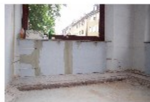
Innendämmung Heizkörper- nische
