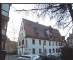
Gebäudeteil West Putz und Fachwerk
