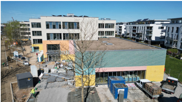
Pilotprojekt Gesamtschule Fitzmauricestraße: Ein Bau dieser Art wurde zuvor in Köln noch nie planerisch wie baulich realisiert. (© Patrick Krausen / Gebäudewirtschaft, Stadt Köln)
