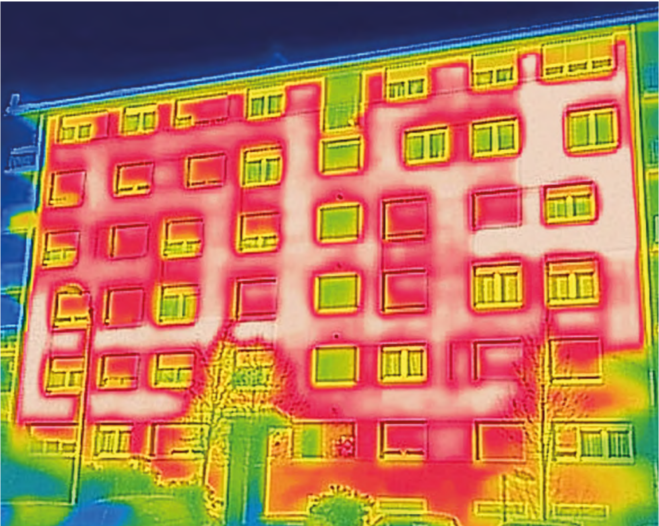
Vor einer Wärmedämmung von Gebäuden steht oftmals die Suche nach Wärmeverlusten etwa mit Thermografie-Aufnahmen (Foto: Colourbox)
