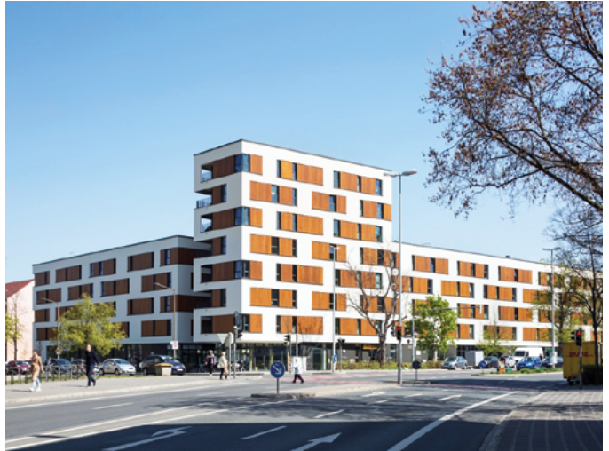
Neues Wohnen Sündersbühl, wbg Nürnberg. Foto: © Stefan Meyer
