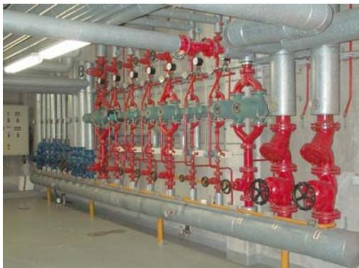
Abb. 4: Veralteter Heizkreisverteiler mit unregelmäßig und doppelten Heizungspumpen vor der Sanierung (Quelle: Stadt Kaiserslautern)
