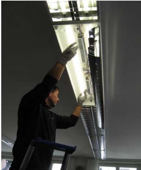
Abb 6: Stromeinsparung durch Entfernen überzähliger Lampen (Quelle: Stadt Freiburg)
