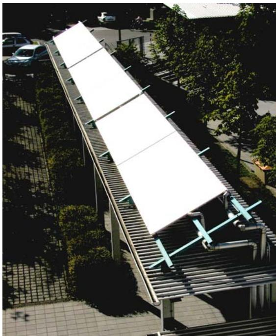
**Abbildung 3:** Solarkollektoren für Duschwasser
