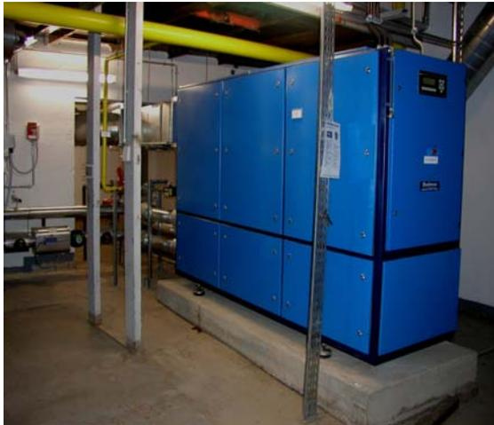
**Abbildung 2:** Erdgas -BHKW (43 kW<sub>el</sub> / 75 kW<sub>th</sub>)
