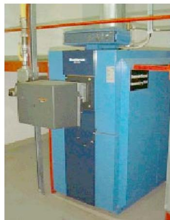
**Abbildung 3:** Dampfkessel und Brennwertkessel
