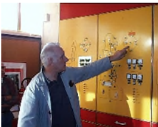
Abb. 2: Haustechniker vor Schalttafel (Quelle: Stadt Hannover)
