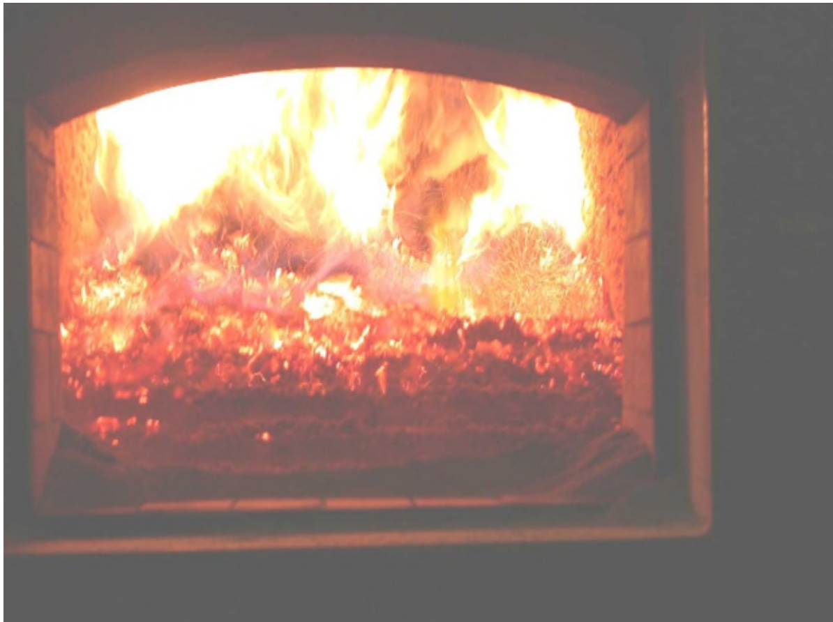
Abb. 3: Blick in eine Hackschnitzelfeuerung
