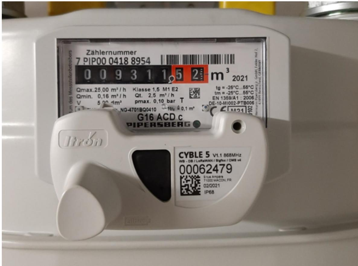
Bild 3: LoRaWAN-Aufsatz bestehender Zähler der Stadtwerke Kiel
