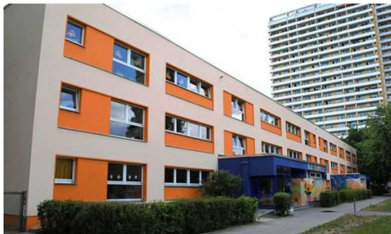
Abb. 2 u. 3: Berlin: Kindertagesstätte Akazieninsel vor und nach der Sanierung
