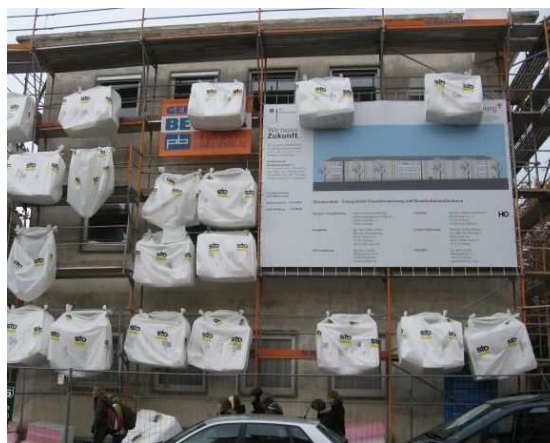
Abb. 10: Stadt Freiburg: Wärmedämmung an der Merianschule
