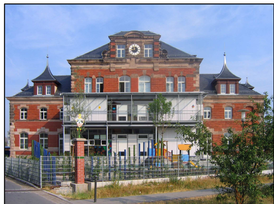
Abb. 1: Stadt Nürnberg: Kindertagesstätte Philipp-Koerber-Weg nach Sanierung
